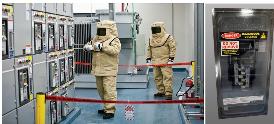
Rysunek 09. Przykład tymczasowej bariery zabezpieczającej dostęp do otwartej szafy
